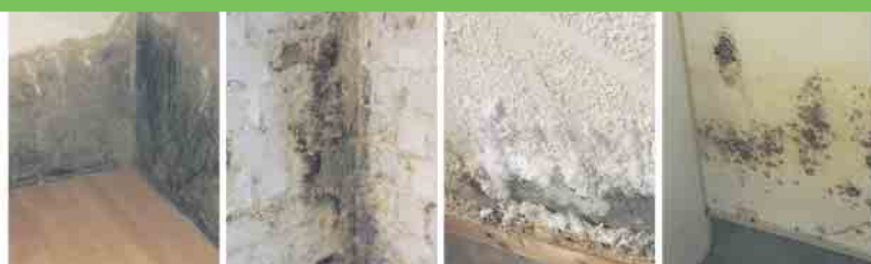
Defekte Horizontalsperre
