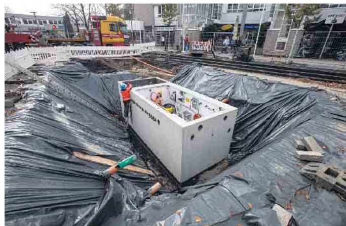
Einbau des Schachtbauwerkes mit Trockenraum und Nassraum
