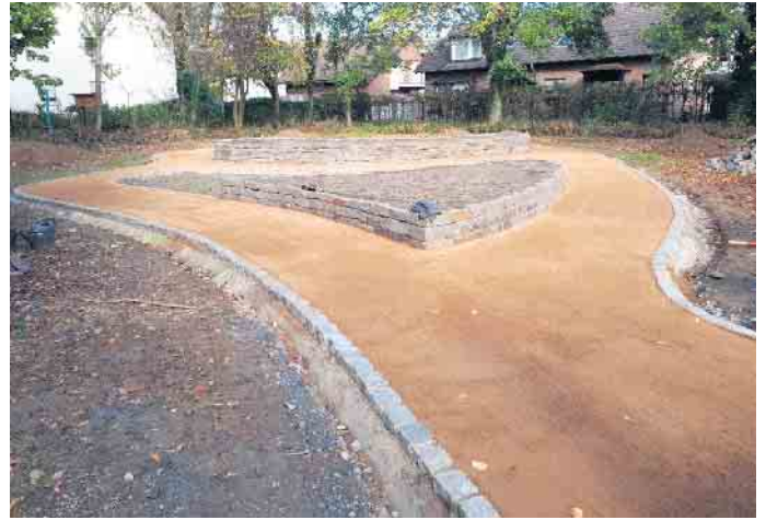
Das Grundgerüst für einen naturnahen Schaugarten ist angelegt.
