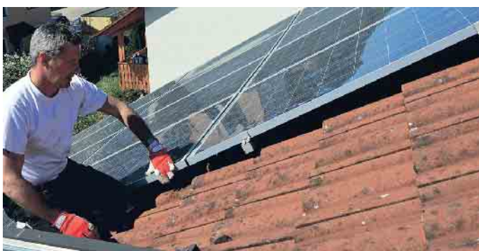
Auch die Begutachtung der Befestigungen von Solaranlagen gehört zum DachCheck. Foto: HF Redaktion/akz-o
