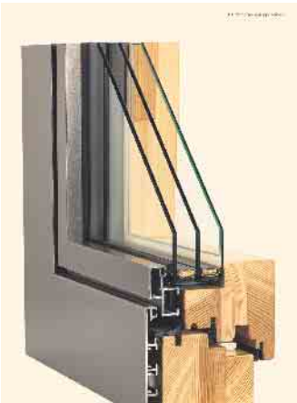
Das Beste zweier Welten miteinander verbinden: Querschnitt durch einen Holz-Aluminium-Fensterrahmen. Copyright Terhalle
