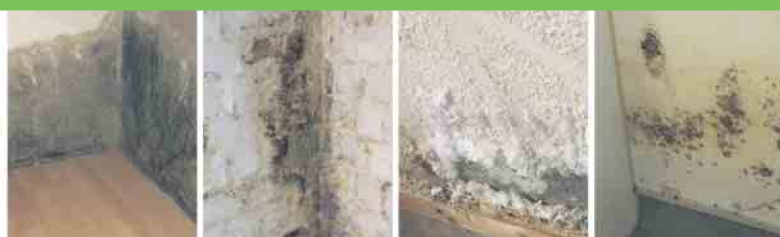
Defekte Horizontalsperre
