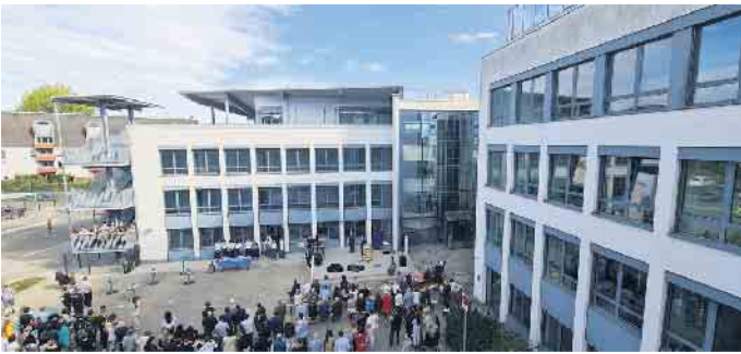
Das Schulgebäude, rechts sieht man den von der Stadtverwaltung genutzten Trakt
