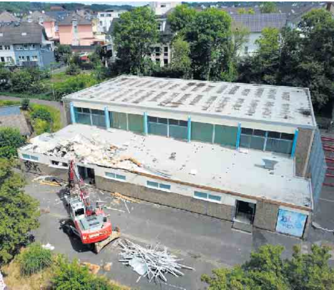
Die alte 1,5-Fach-Sporthalle wird abgerissen, um Platz für eine neue, moderne Zweifach-Sporthalle zu schaffen.
