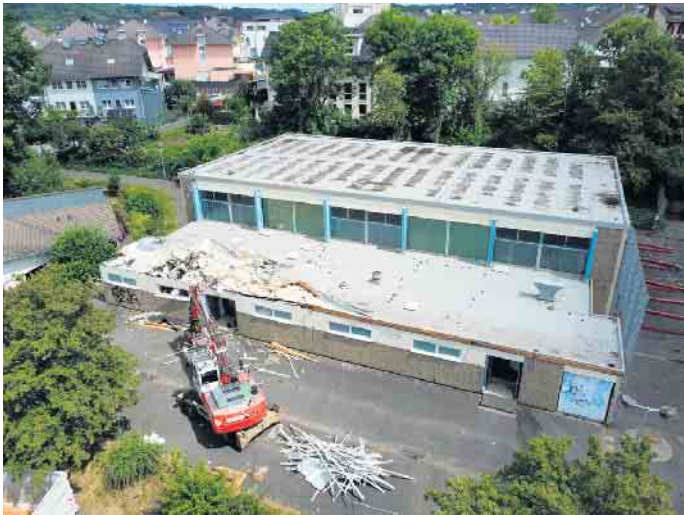
Die alte 1,5-Fach-Sporthalle wird abgerissen, um Platz für eine neue, moderne Zweifach-Sporthalle zu schaffen.
