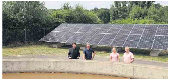
Vor der Photovoltaik-Anlage auf der Kläranlage in Hennef-Dondorf (v.l.): Bürgermeister Mario Dahm, Dr. Volker Erbe, Dana Schmetkamp und Manfred Thomé.
