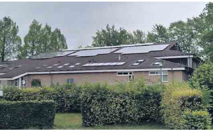
Die Dachkonstruktion der Sporthalle Meiersheide ist saniert.
