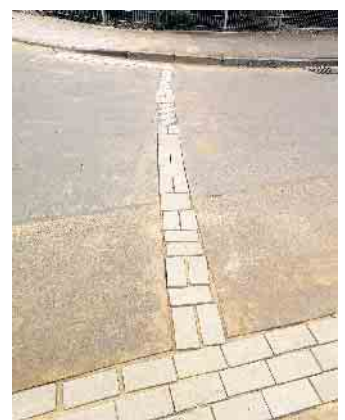
Provisorische Befestigung mit Betonsteinpflaster auf der Straße „Am Kuckuck“.
