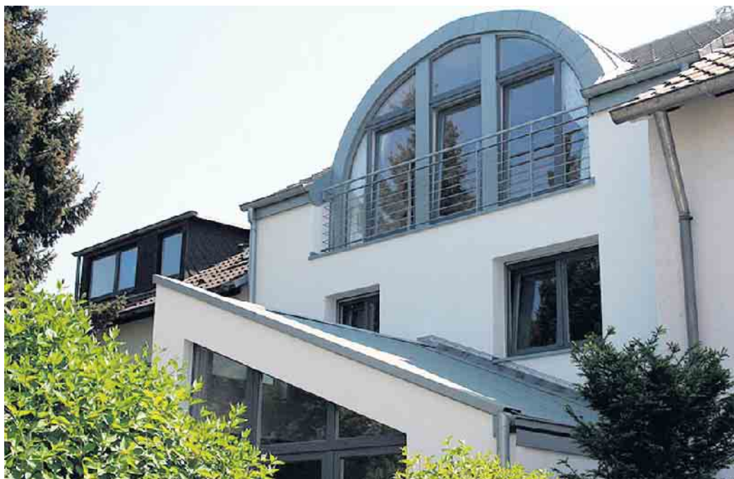
Große Fensterfronten in den oberen Stockwerken sind ein Hingucker, müssen aber gut gesichert sein.
