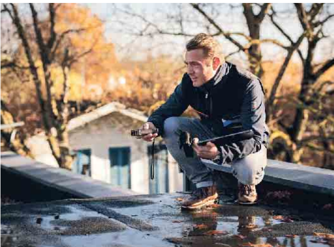
Sensoren überwachen Flachdächer und messen den Feuchtigkeitsgehalt. Foto: smart roof solutions/akz-o
