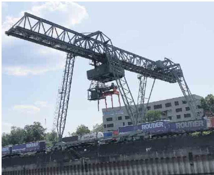
Container-Kranbrücke im Niehler Hafen
