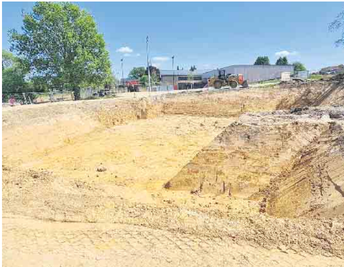
Die Baugrube ist vorbereitet.
