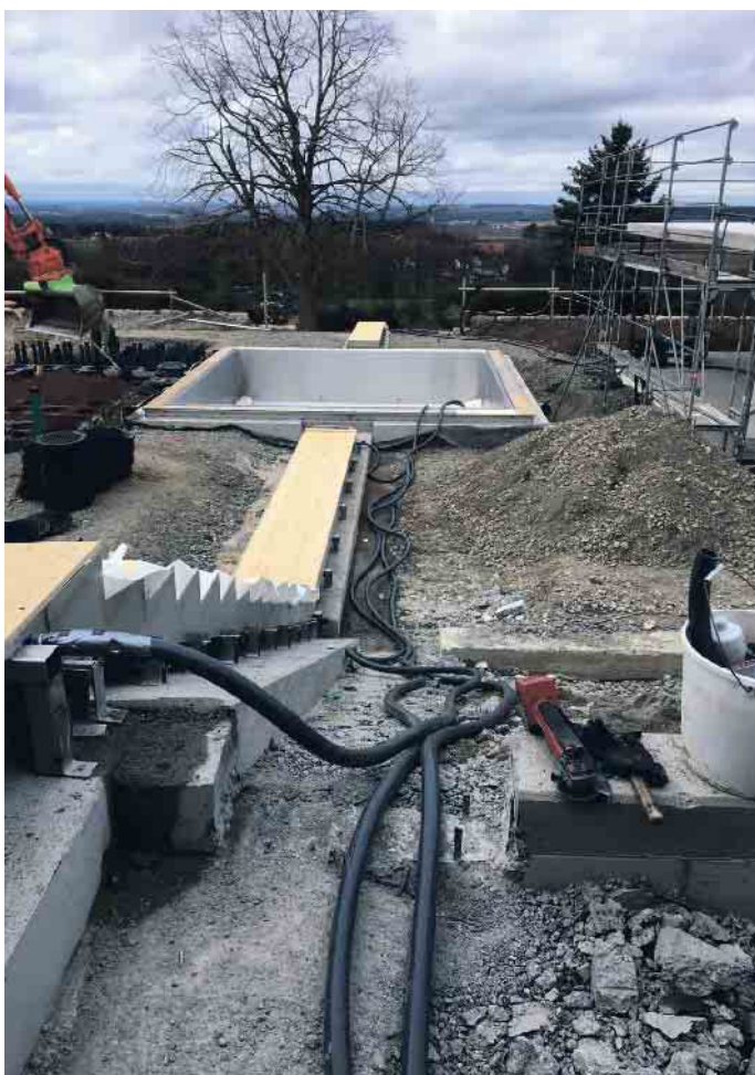
Ein Pool entsteht. Foto: Sorg Schwimmbäder/akz-o
