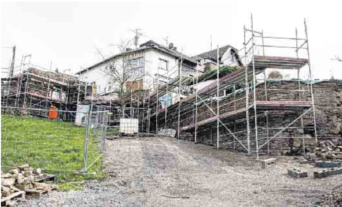
Mauersanierung am Kölner Tor in Stadt Blankenberg
