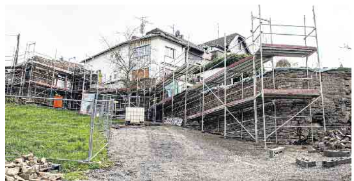
Mauersanierung am Kölner Tor in Stadt Blankenberg
