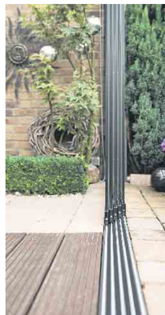
Ganzglas-Schiebeanlagen zeichnen sich durch eine besonders schlanke Konstruktion aus. Sie werden auf Laufschielen geführt. Foto: DJD/Bundesverband Wintergarten e.V.
