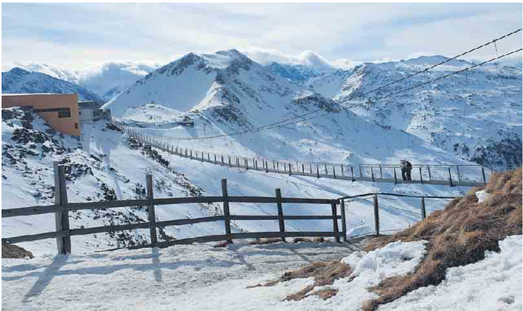
Hängebrücke am Stubnerkogel
