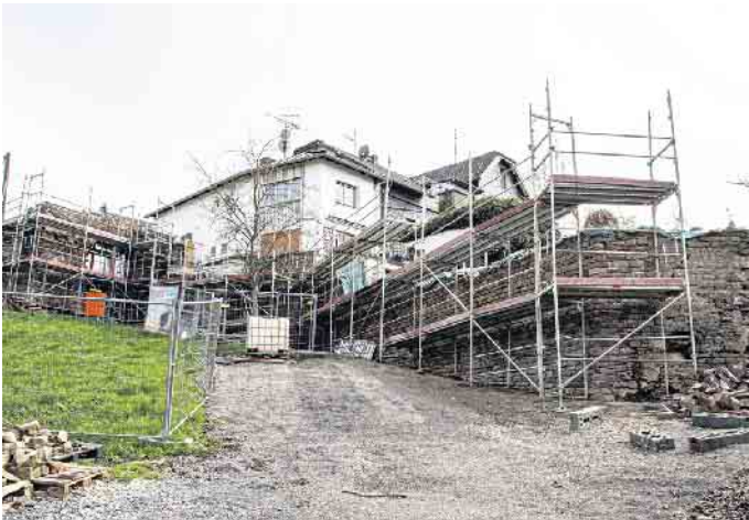
Mauersanierung am Kölner Tor in Stadt Blankenberg
