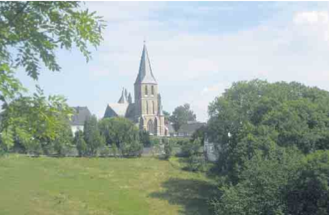
Die Wallfahrtskirche in Bödingen ist eine weithin sichtbare Landmarke.
