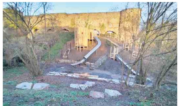
Der neue Spielplatz in Stadt Blankenberg ist fast fertig gebaut.
