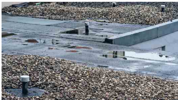
Ein Flachdach wie dieses mit stehendem Wasser und Rissen in den Dachbahnen sollte dringend saniert werden. Foto: Datenschutz-Stockfoto/shutterstock/Triflex/akz-o
