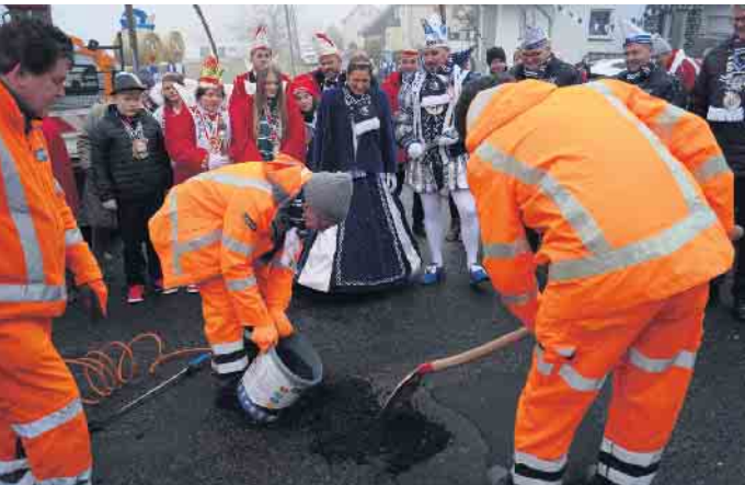
... dann mit Schotter auffüllen ...
