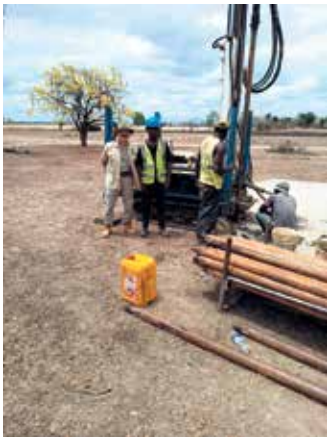
Bohrarbeiten in Makutere / tansanische Savanne bis ca. 80 m Tiefe
