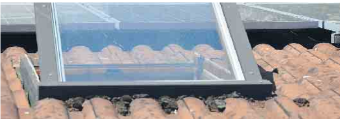
Anschlüsse an Dachdurchdringungen bei Dachfenstern werden beim DachCheck begutachtet. Foto: HF Redaktion/akz-o
