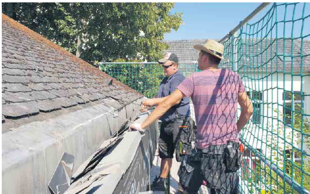
Verklammerung und Befestigung der Dachziegel bzw. -platten werden beim DachCheck geprüft. Foto: ZVDH/akz-o
