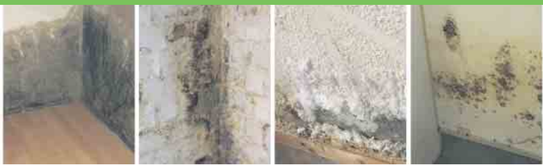
Defekte Horizontalsperre Querdurchfeuchtung Ausblühungen Schimmelbefall
