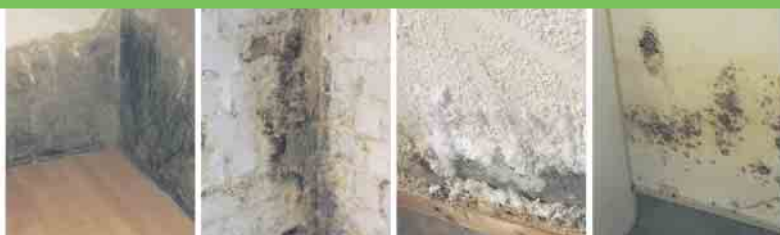
Defekte Horizontalsperre
