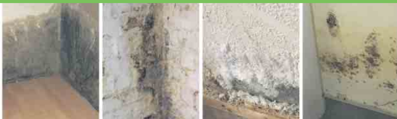
Defekte Horizontalsperre
