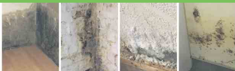
Defekte Horizontalsperre
