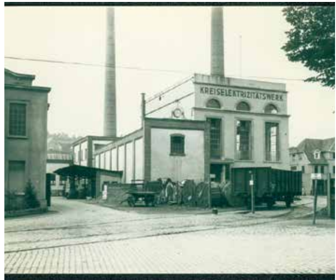
Kreiselektrizitätswerk Dieringhausen Mitte der 1920er-Jahre
