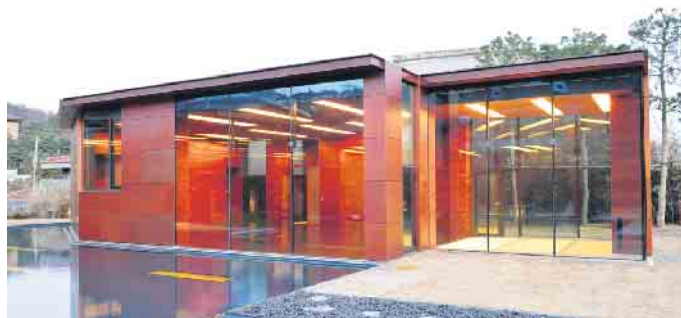
Gerade bei großen Fensterflächen ist selbstreinigendes Glas sinnvoll. © Okalux Glastechnik GmbH/In ho Lee.
