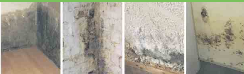
Defekte Horizontalsperre
