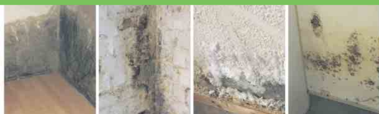
Defekte Horizontalsperre
