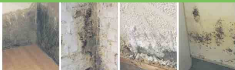
Defekte Horizontalsperre
