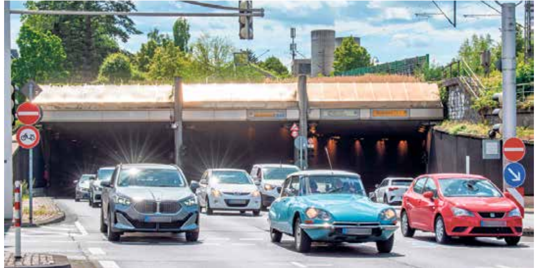
Die Technik im Straßentunnel Bad Godesberg - hier das nördliche Tunnelportal an der Ecke zur Wurzerstraße - muss dringend erneuert werden. Foto: Sascha Engst/Bundesstadt Bonn
