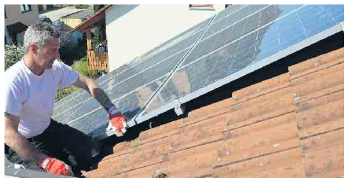
Der qualifizierte Dachdecker prüft die Befestigungen der Solarmodule und begutachtet die Unterkonstruktion im Rahmen des DachChecks. Foto: HF Redaktion/akz-o
