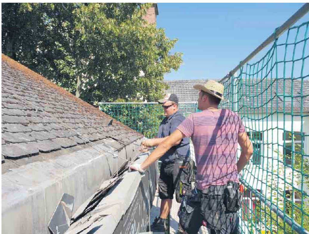
Verklammerung und Befestigung der Dachziegel bzw. -platten werden beim DachCheck geprüft. Foto: ZVDH/akz-o
