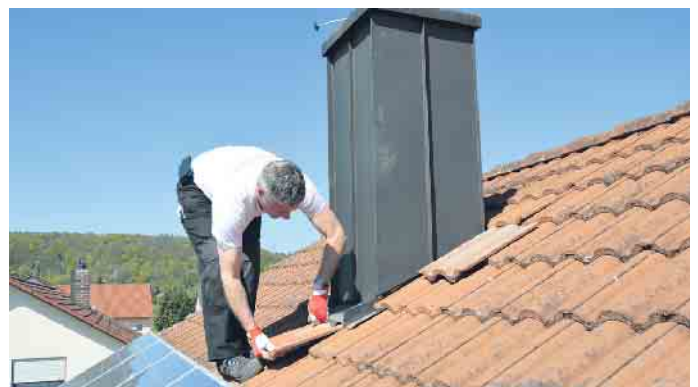
Anschlüsse an Dachdurchdringungen werden beim DachCheck begutachtet. Foto: HF Redaktion/akz—o
