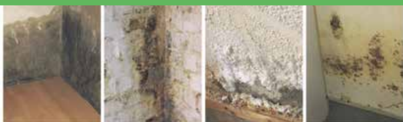
Defekte Horizontalsperre
