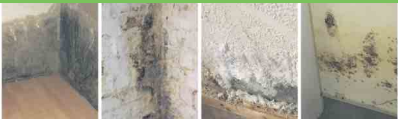
Defekte Horizontalsperre Querdurchfeuchtung Ausblühungen Schimmelbefall
