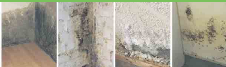
Defekte Horizontalsperre
