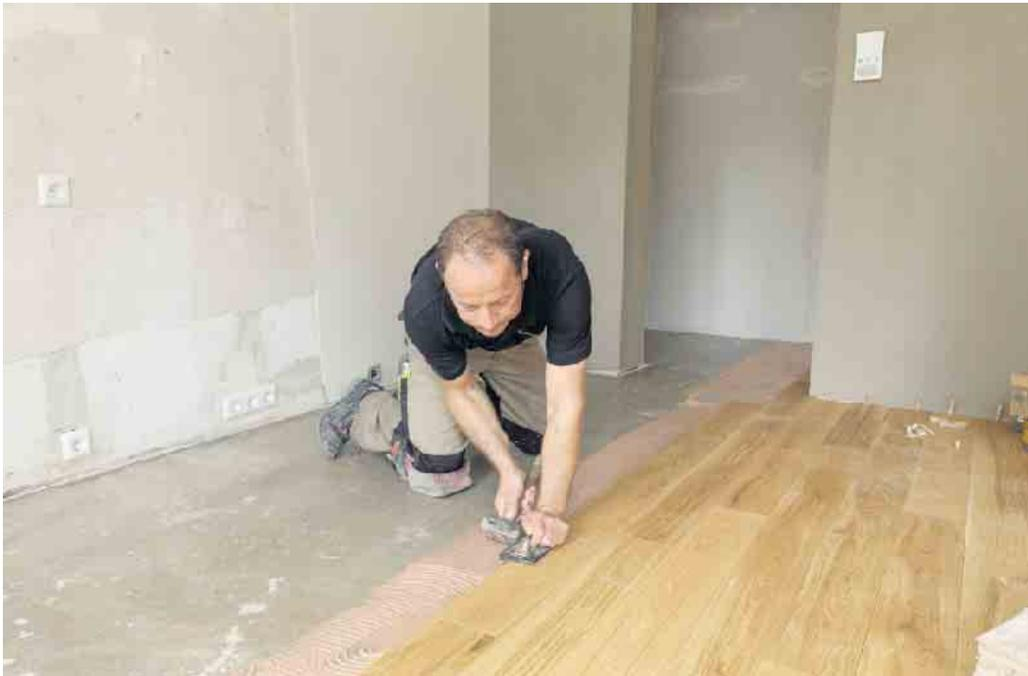
Ein Profi klebt die Eichendielen vollflächig auf den Untergrund. Das sichert eine gute Wärmeübertragung durch die Fußbodenheizung und sorgt für einen niedrigen Trittschall. Der eingesetzte Klebstoff trägt das Emicode-Zeichen EC 1. Dieses Siegel gewährleistet geringste Emissionen und schützt die Gesundheit der Verarbeiter und Bewohner. Foto: Initiative Parkett im Klebeverbund (PIK)
