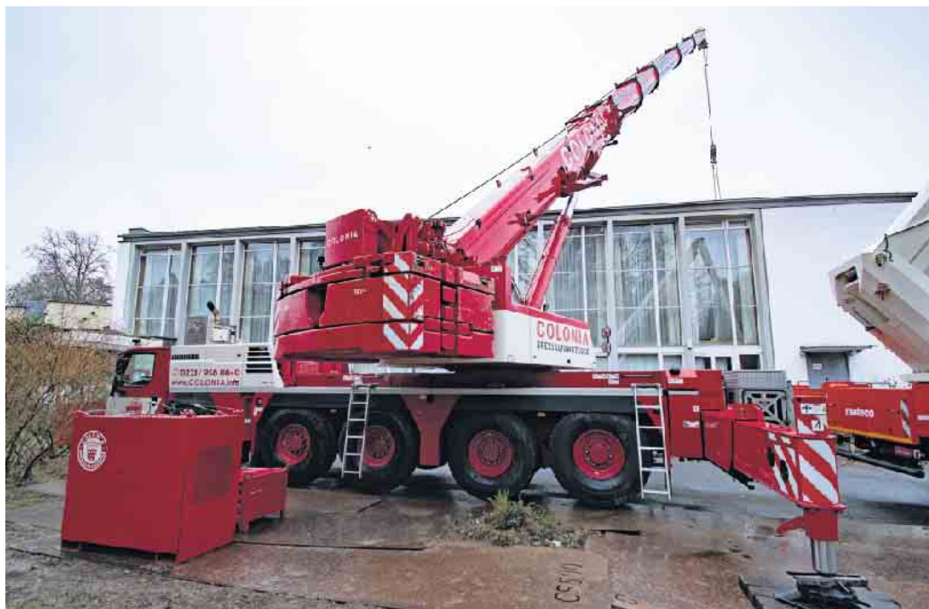
Mit Hilfe eines Autokrans, der an der Stadthalle Bad Godesberg aufgestellt ist, werden die einzelnen Träger des Großen Saals gesichert. Fotos: Sascha Engst/Bundesstadt Bonn
