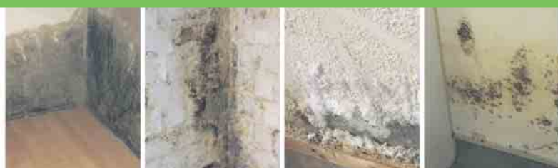
Defekte Horizontalsperre Querdurchfeuchtung Ausblühungen Schimmelbefall
