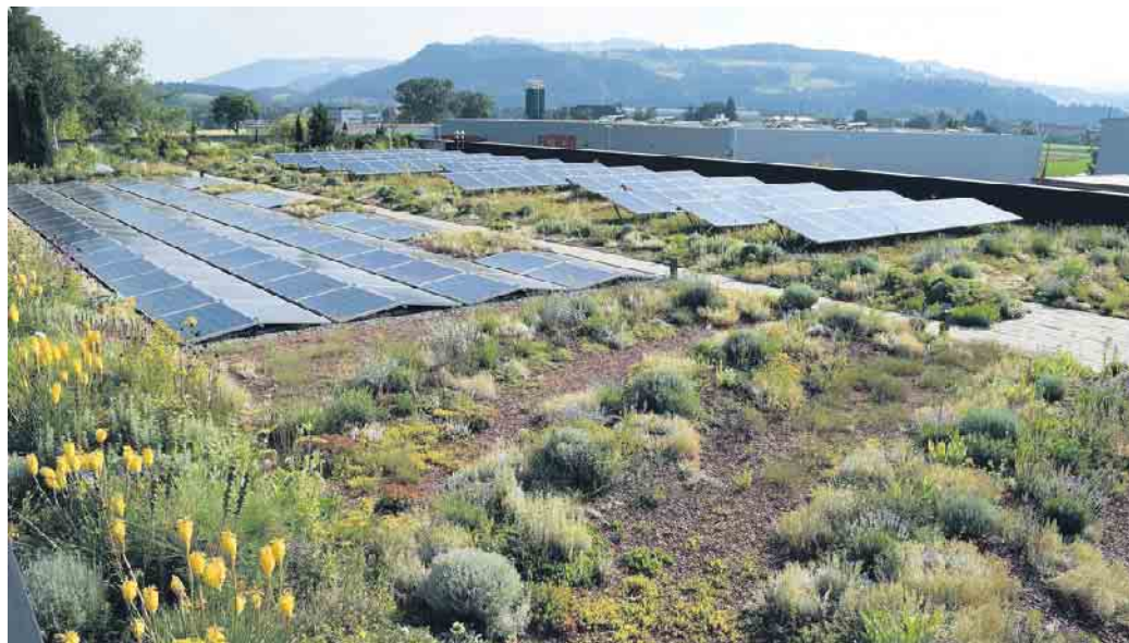
Die perfekte Kombi: Photovoltaik und Gründach. Foto: Bundesverband GebäudeGrün e.V./akz-o
