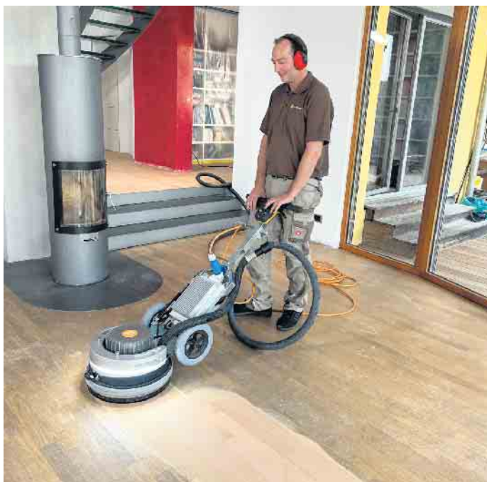
Nach einem Abschleiff glänzt Parkett wieder wie neu. So kann es viele Jahrzehnte verwendet werden. Foto: Pallmann
