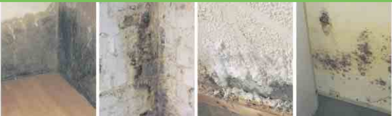
Defekte Horizontalsperre Querdurchfeuchtung Ausblühungen Schimmelbefall
