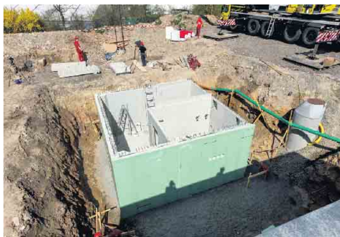
6,50 mal 6,50 Meter Baugrube reichen für einen kompakten Teilkeller meist schon aus. Foto: GÜF/Glatthaar Keller
