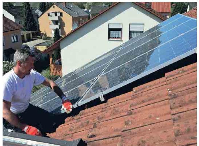
Auch die Begutachtung der Befestigungen von Solaranlagen gehört zum DachCheck. Foto: HF Redaktion/akz-o
