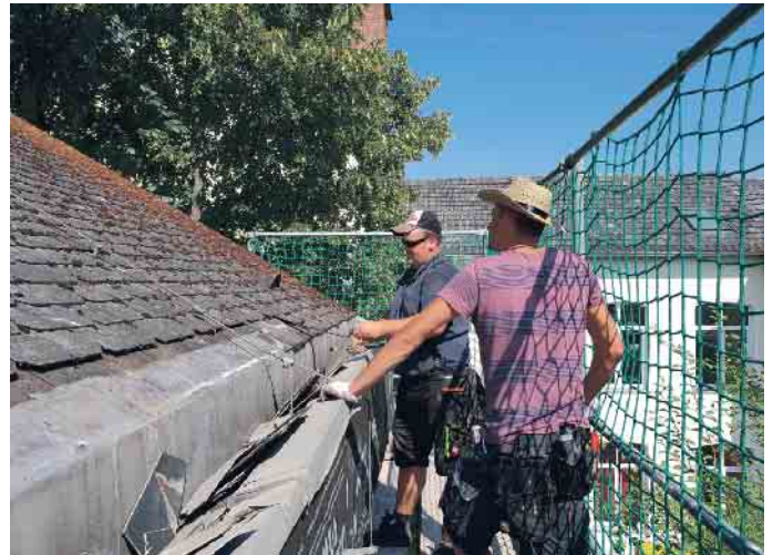
Verklammerung und Befestigung der Dachziegel bzw. -platten werden beim DachCheck geprüft. Foto: ZVDH/akz-o
