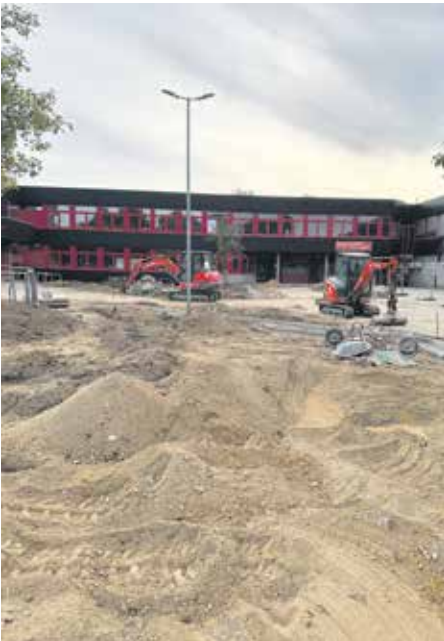
Die Arbeiten auf dem Vorplatz sollen bis zum Frühjahr 2027 abgeschlossen sein, ehe bis Ende 2027 auch die Umgestaltung des Schulhofes fertig sein wird.
