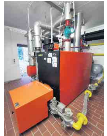
Die Gasheizung aus dem Jahr 1986 und auch weitere Anlagen haben ihre technische Lebensdauer längst überschritten und müssen erneuert werden.
