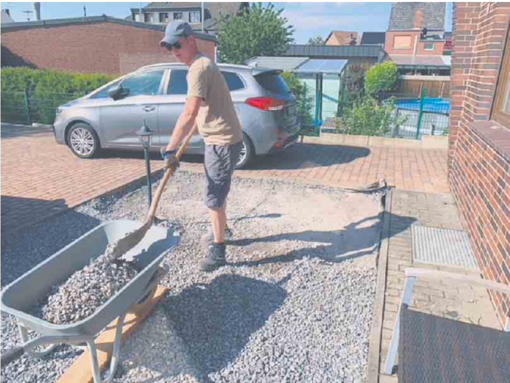
Im ersten Schritt wurde der Schotter entfernt
