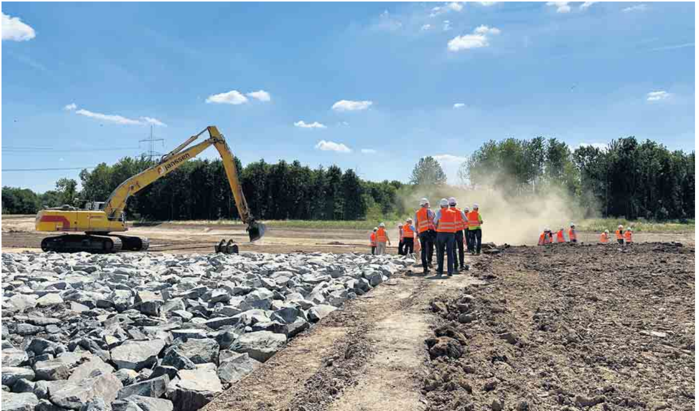
Führung auf der aktiven Baustelle der Erft-Verlegung. Foto: Erftverband
